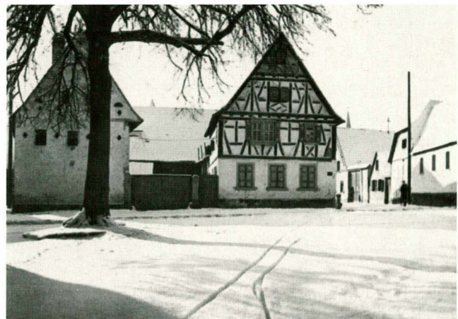
Alte Linde mit Fachwerkhaus
