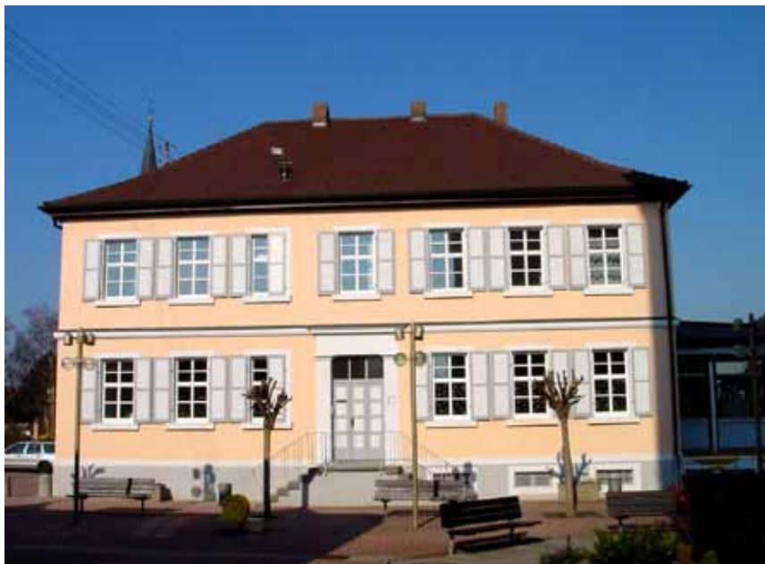
Schulhaus von 1827/28, heute Kindergarten
